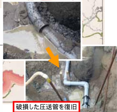
破損した圧送管を復旧
