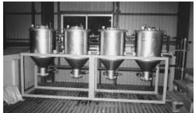
写真 アンモニア除去装置（ゼオライト槽部分）
