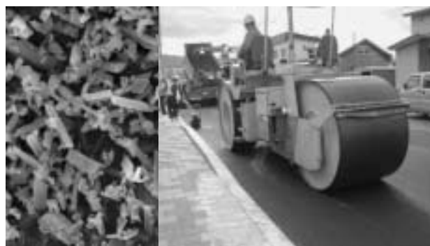
写真 ホタテ貝殻粉砕物（左）とそれを充填材として活用したアスファルトの試験施工
