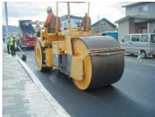
図1 試験施工（国道242号生田原町市街）
