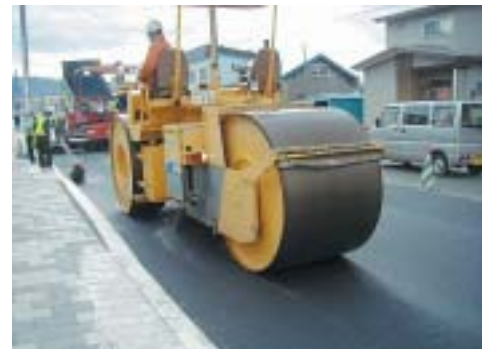
P 5 ホタテ貝殻粉末を利用したアスファルト舗装
