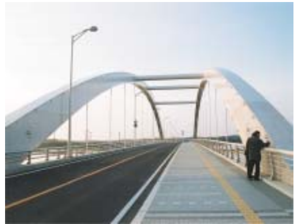
図1 鋼道路橋のアーチリブへの防食溶射実施例（福岡市一海の中道大橋）
