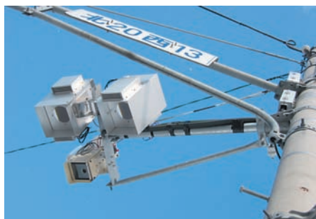
本方法を適用した路面水分検知センサ
