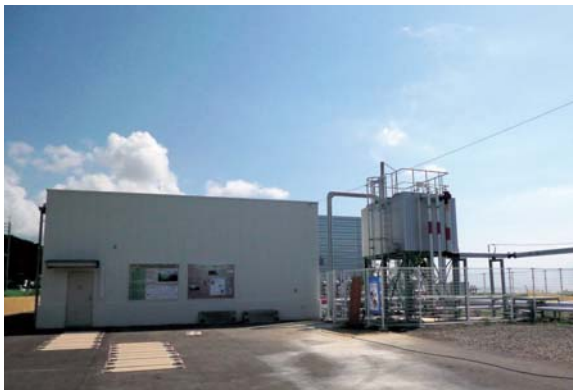
発電所全景：左の棟内部に発電機等を設置。右は貯湯槽。
