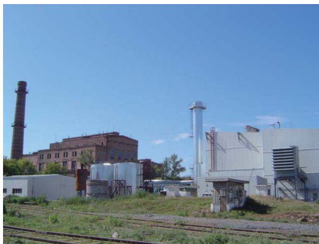
既設火力発電所本館(左の茶色の建物)と H-25熱電併給設備(右の白色の建物)の外観
