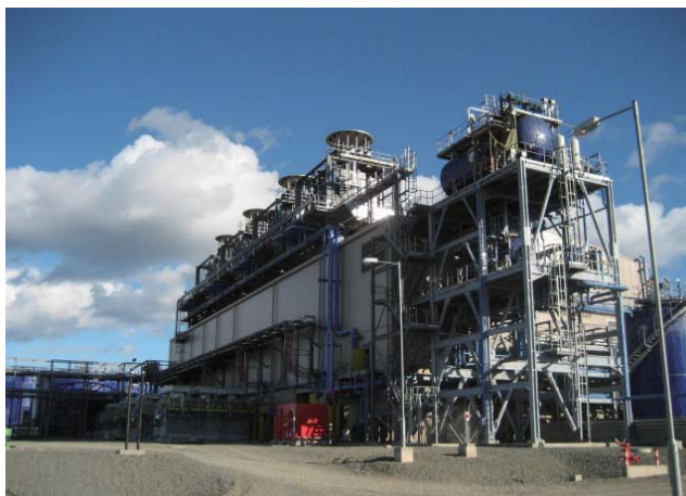
ガスタービン発電機建屋全景(左)と、ガスタービン発電機建屋(手前:潤滑油クーラ、屋根上:排熱回収ユニット)(右)
