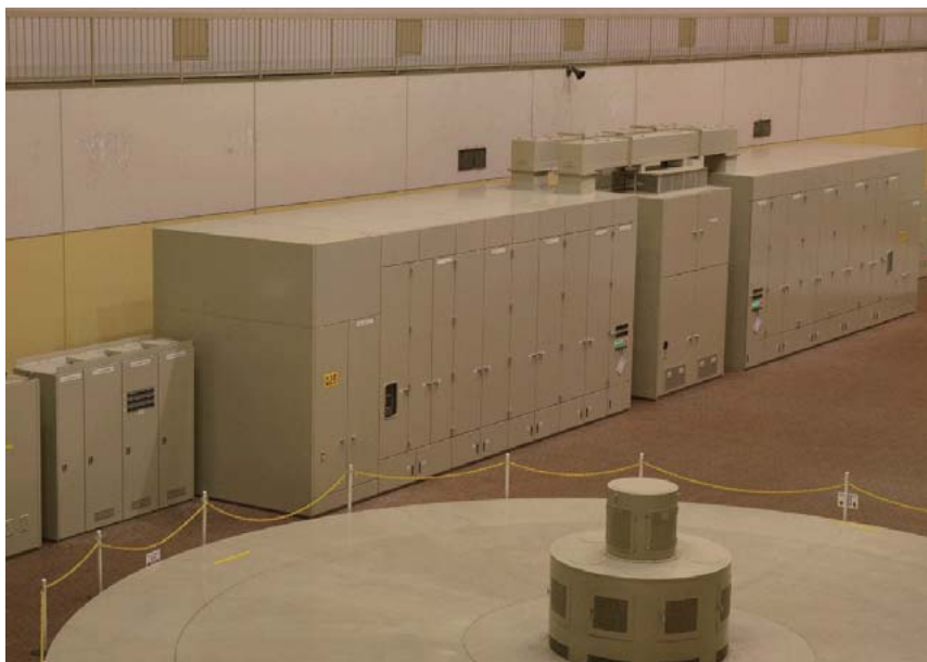
4 東北電力株式会社第二沼沢発電所向けサイリスタ起動装置
