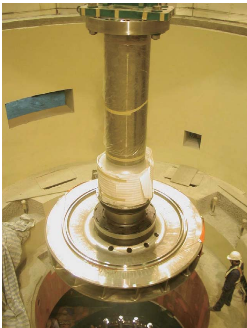
3 台湾電力公司谷関発電所初号機のランナ吊り込み
