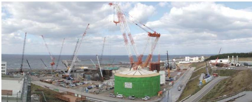
1 島根原子力発電所3号機の大型クローラークレーンでの原子炉圧力容器搬入状況(上)と大間原子力発電所の原子炉格納容器の地上組み立て状況(中央手前)(下)
