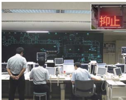
3 新大阪指令所の大型運行表示盤と抑止表示機（右上）
