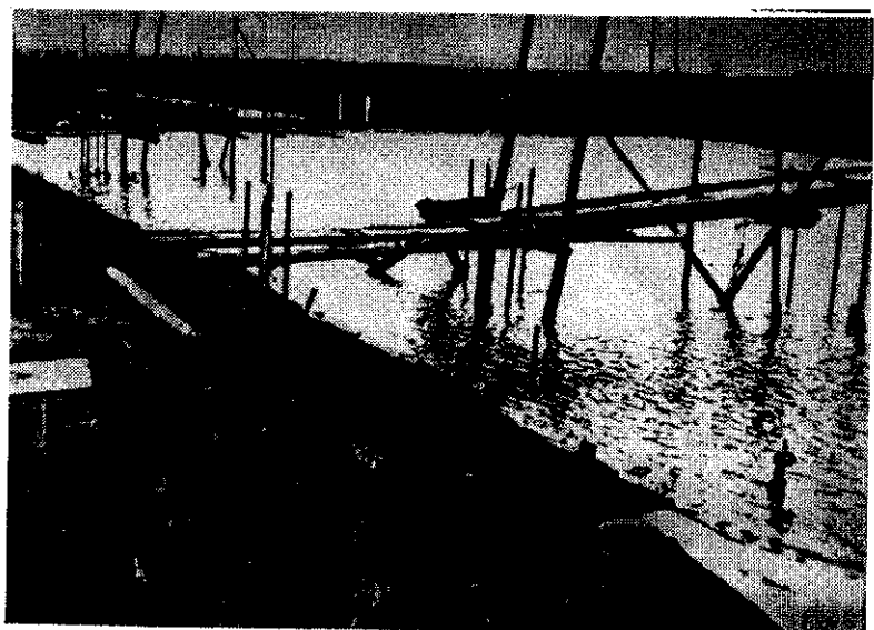
湛水試験 32年 第3回試験 水位2.0m
