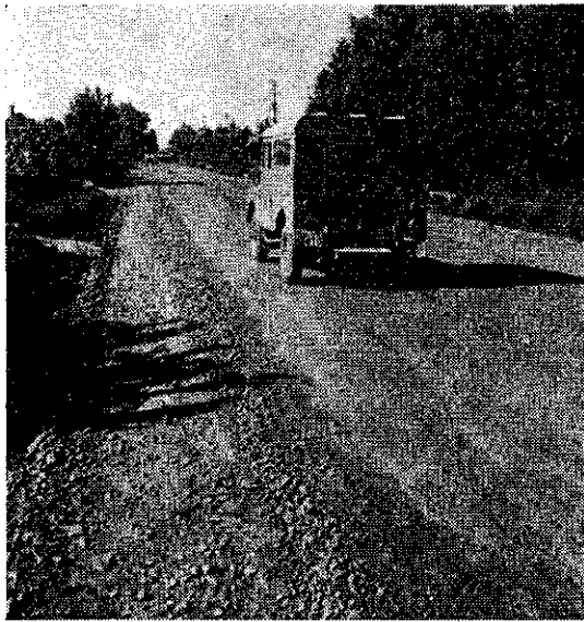
写真-6 施工後約2ヵ月経過（区間C付近）
