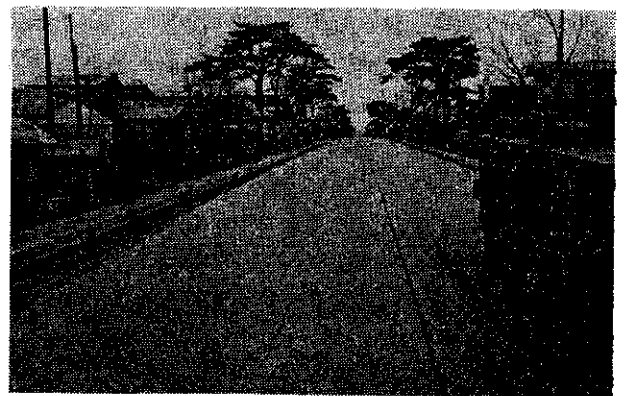
写真-9 15年間供用中の5号、亀田市桔梗付近
