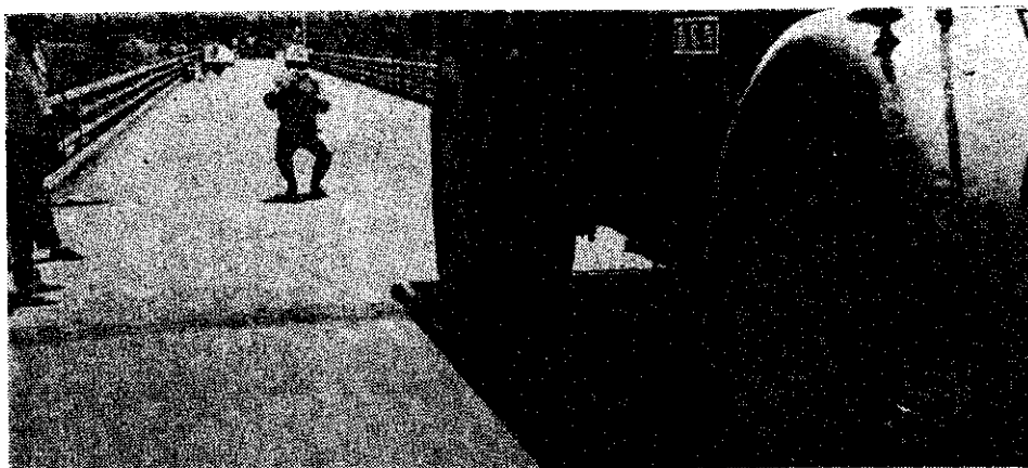
写真-4 天塩大橋載荷状況（載荷状態 1）
