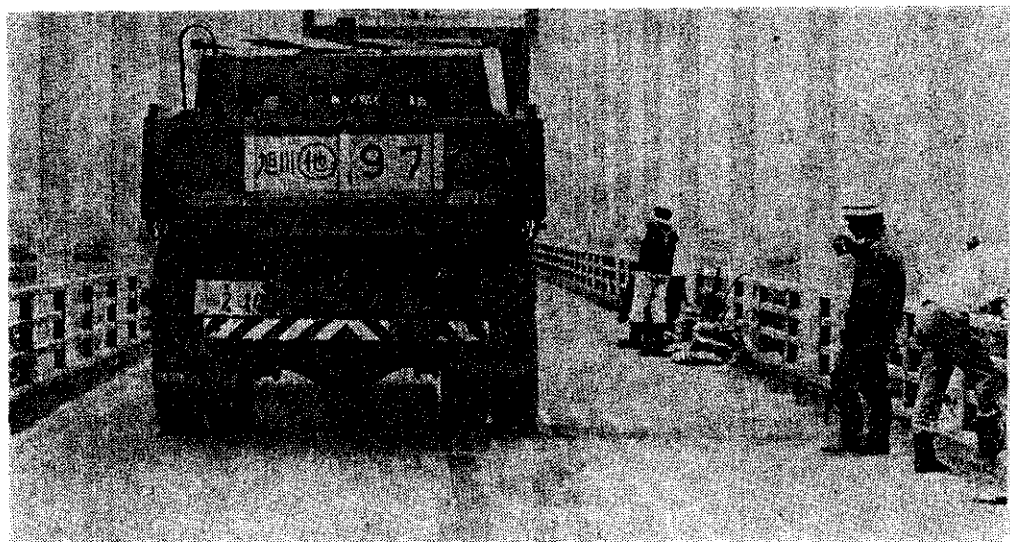
写真-5 天塩大橋載荷状況（載荷状態 2）
