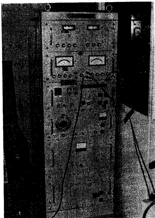
写真—3 制 御 装 置
