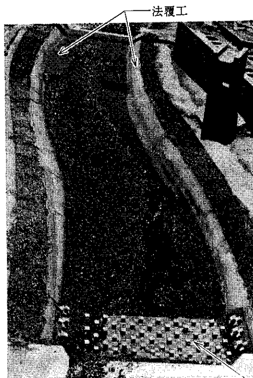
写真-3 法覆工・護床工
