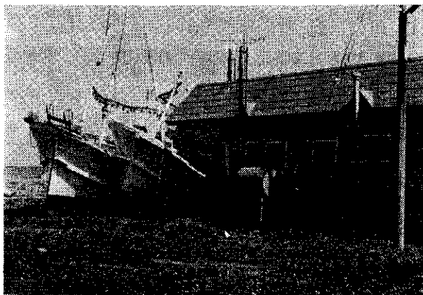
写真-6 江差道路事務所の青苗分駐所の被災 (上架していた漁船が激突して、分駐所の角が破壊した。) (左側には、海岸護岸から打ち上げられたテトラポットが見える。)
