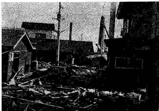
写真-5 青苗地区の被災状況 (青苗岬の先端から約 170 m の地域。) 家屋の被害が集中した。
