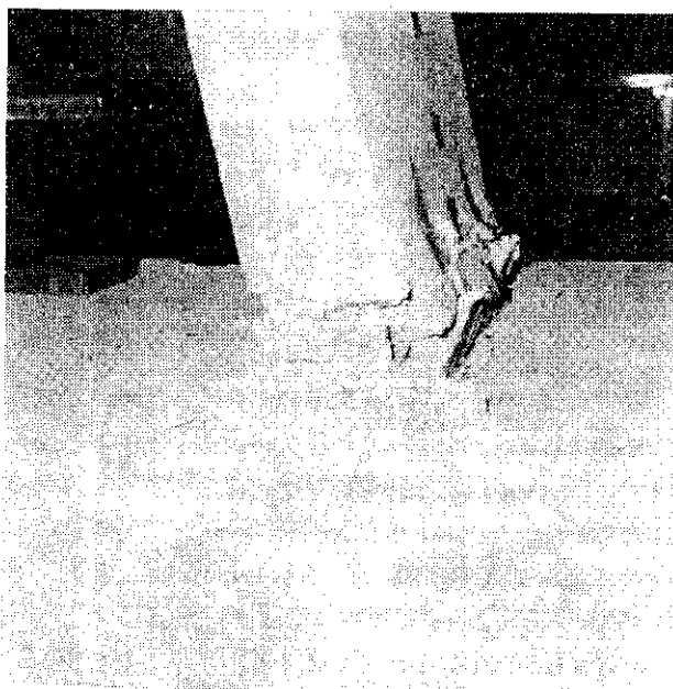
写真-1 A-RC 破壊状況
