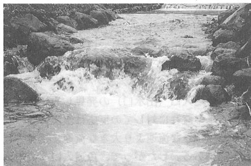
写真-1 巨石投入による魚道
