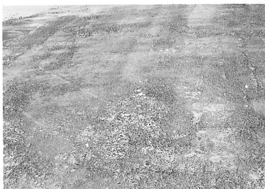
写真-2 材令40時間でグリーンカットを行ったコンクリート
