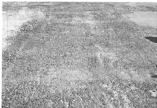
写真-1 材令24時間でグリーンカットを行ったコンクリート
