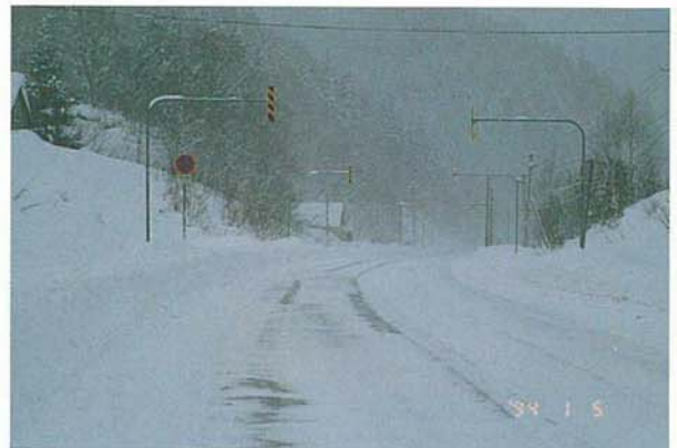
写真-9 冬期一般国道 230 号新型スノーポールの設置状況 (小雪 その2)
