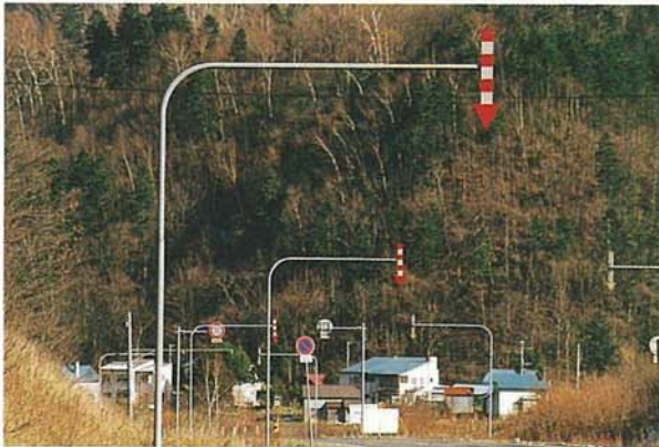
写真-6 秋期一般国道 230 号従来型スノーポールの設置状況 (背景 茶褐色)
