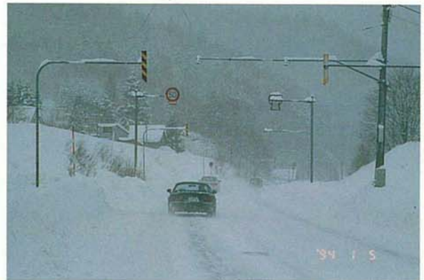
写真-8 冬期一般国道 230 号新型スノーポールの設置状況 (小雪 その1)
