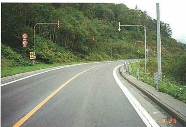
写真-7 夏期一般国道 230 号従来型スノーポールの設置状況 (背景 緑)
