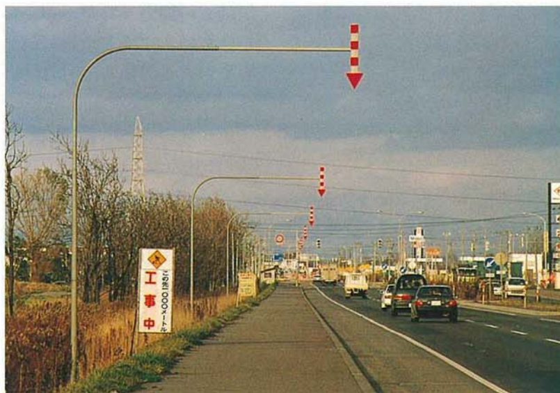
写真-4 一般国道 275 号従来型スノーポールの設置状況
