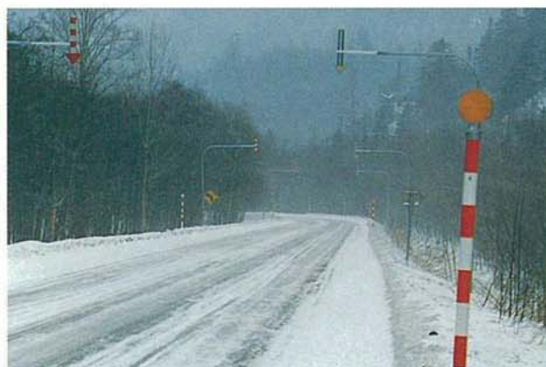
写真-12 冬期一般国道 230 号従来型スノーボールの設置状況 (小雪)
