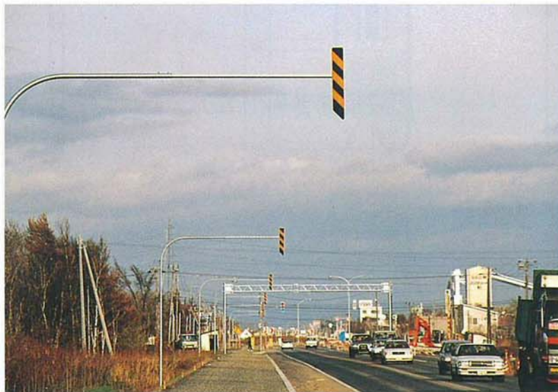
写真-3 一般国道 275 号新型スノーポールの設置状況
