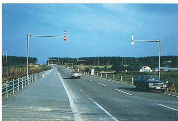
写真-21 スノーボール（固定式視線誘導柱） アームフランジ型の設置例
