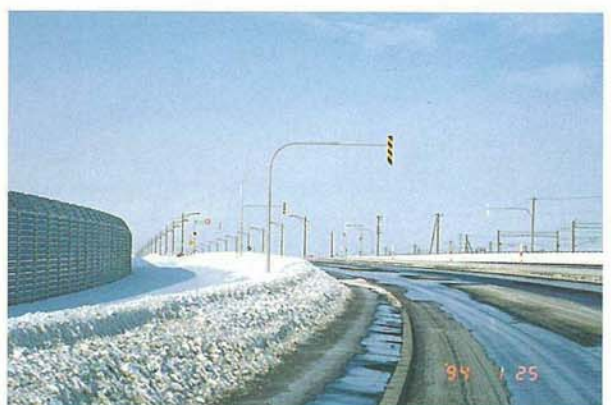
写真-10 冬期一般国道 12 号新型スノーポールの設置状況 (晴)
