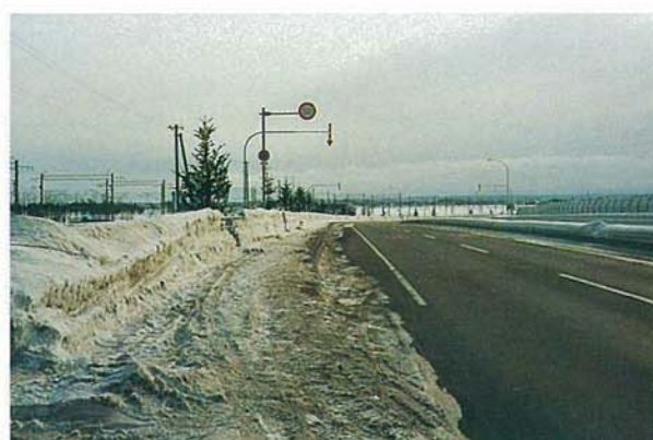
写真-13 冬期一般国道 12 号従来型スノーボールの設置状況 (晴)
