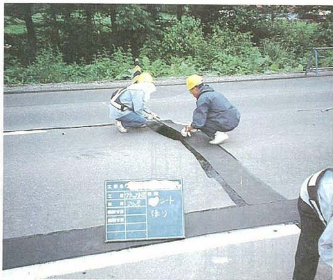
写真-3 シート材による補修例（瀝青シートタイプ）
