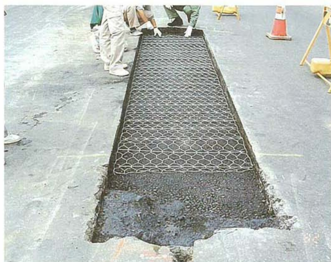
写真-2 シート材による補修例 (メッシュタイプ)
