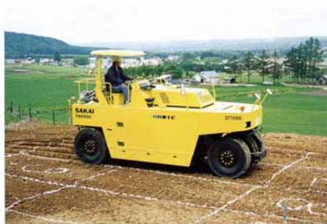
写真-2 締め固め状況
