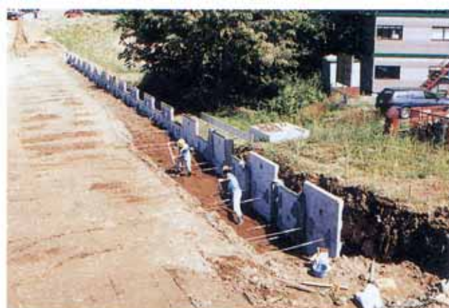
写真-3 多数アンカー施工状況
