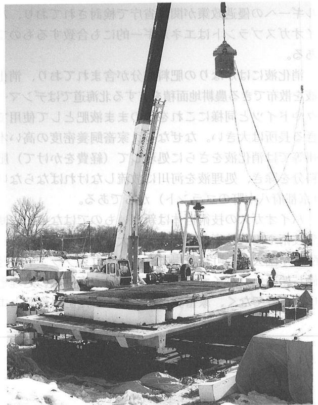
衝撃載荷実験(江別市角山実験場)
