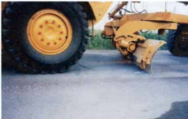
図-3 グレーダ走行状況
