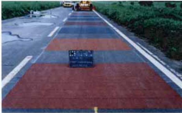
図-2 滑り止め舗装敷設 全景
