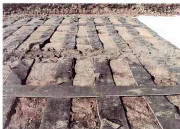
写真一1 水平ドレーンの設置状況
