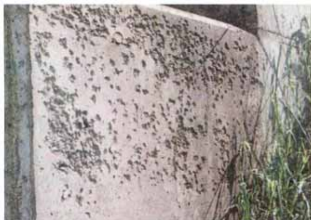
写真-1 橋台コンクリートの凍害（表面剥離）
