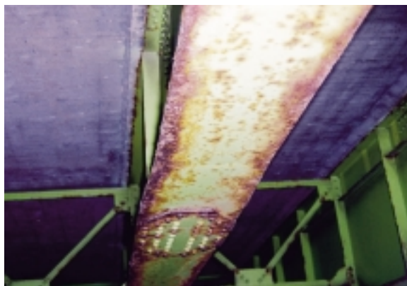
写真 - 8 C橋の劣化状況
