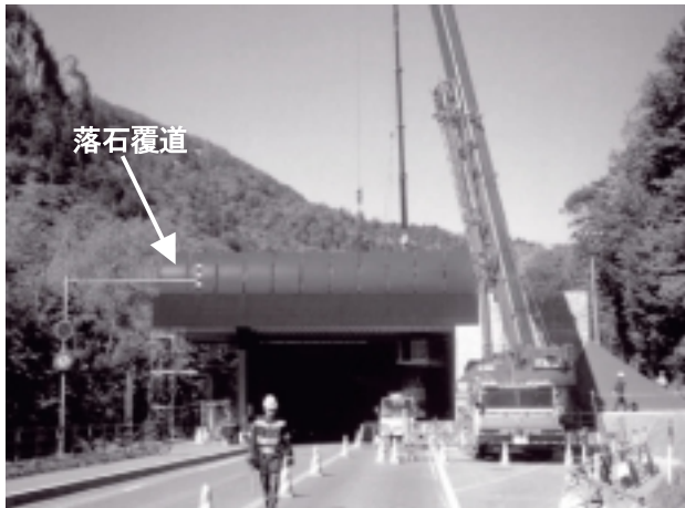
写真 - 1 屏風岩覆道
