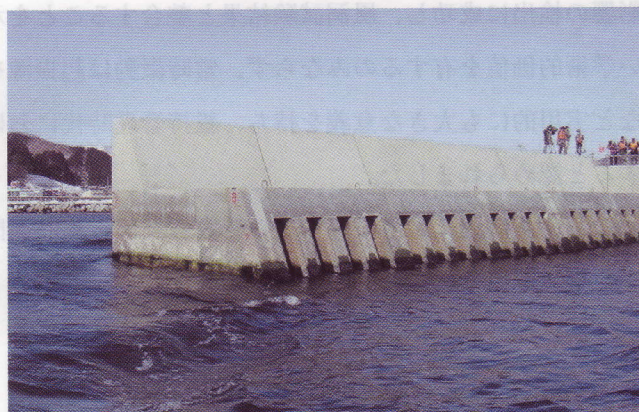
福島漁港 斜面スリットケーソン式防波堤
