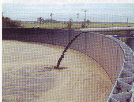
生成した液肥を貯留槽へ 流し込んでいるところ
