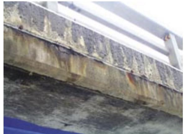
写真-2 凍結防止剤が散布される内陸部の橋梁の錆汁
