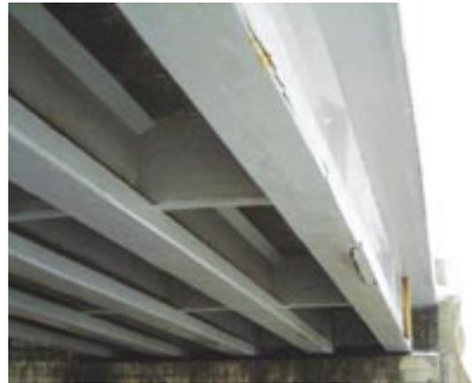
写真-1 塩害によりひび割れが生じたPC橋
