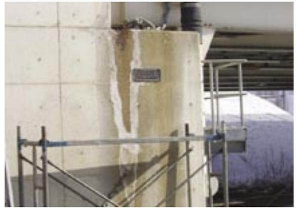
写真－3 下部工への凍結防止剤を含む水の供給
