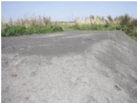
写真－6 9 ヶ月後の盛土状況
