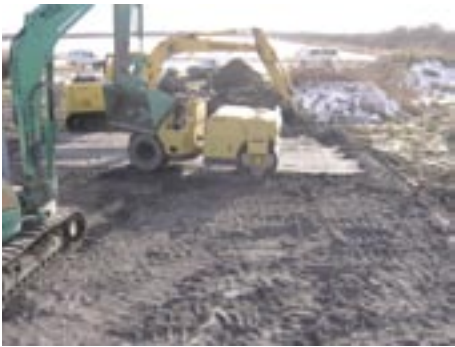
写真－5 施工状況
