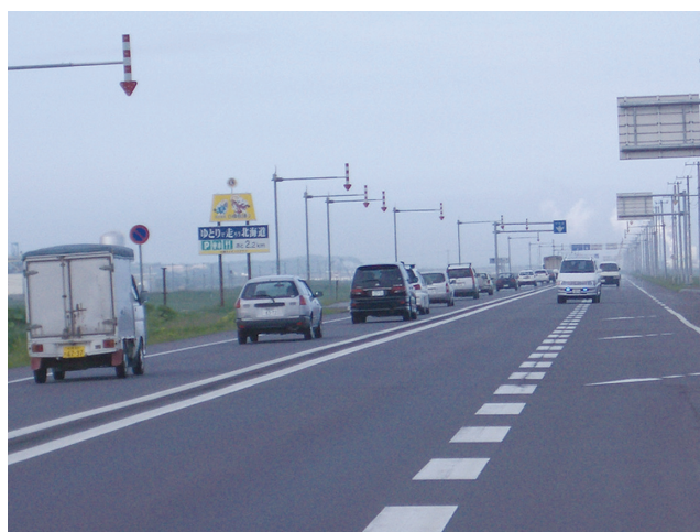
写真-1 一般国道38号白糖町の付加車線区間
