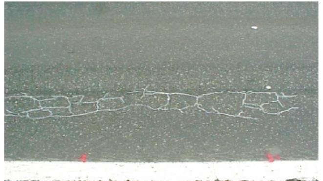
写真-1 A断面に発生した疲労ひび割れ
