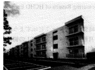
Photo 2 実験住宅 (東京・調布市) (View of Test Housing)
