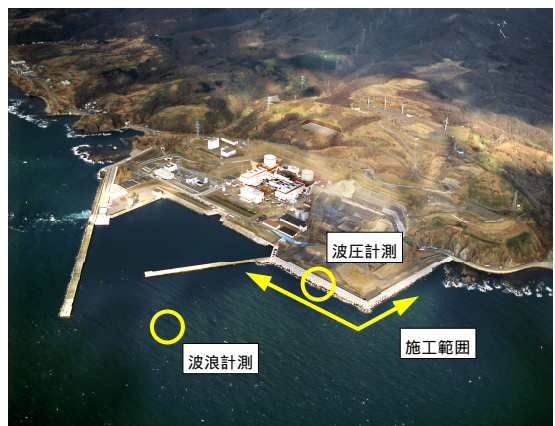
Photo 3 施工範囲と現地計測実施地点 (Place of Field Survey)
