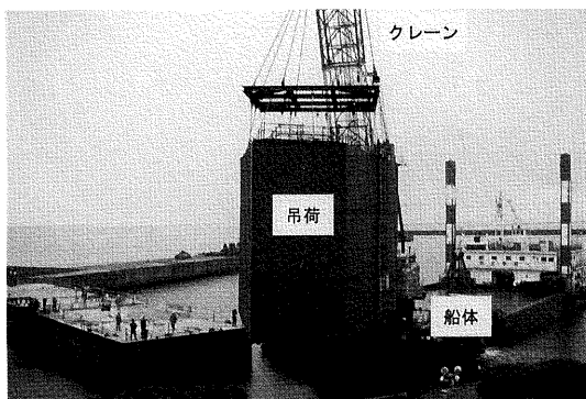
Photo 1 クレーン船による積荷の据付 (Placing of Cargo by Floating Crane)
