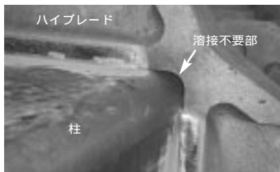
図4 柱とハイブレードの溶接
