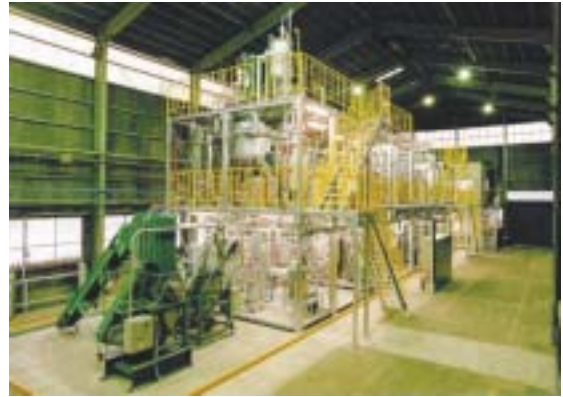
図1 パイロットプラント
