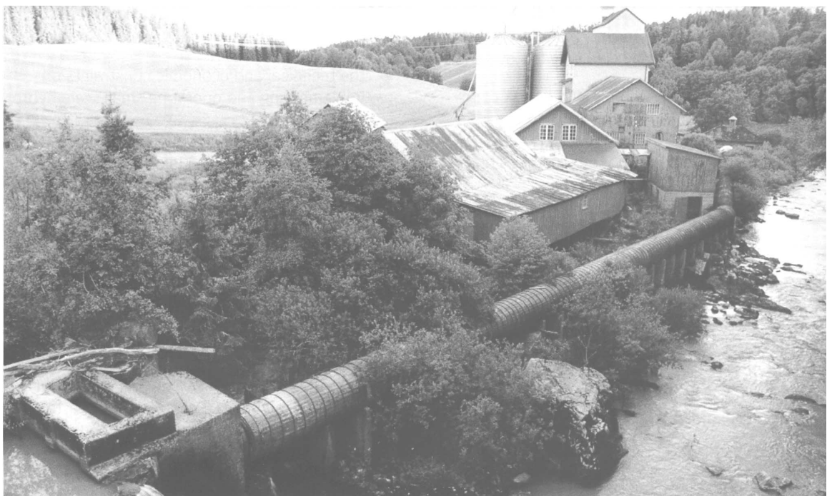
軽工業向けの電力を供給するエスト フォル（Ostfold）の設備容量 450kWのプラント
