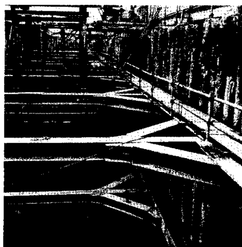
写真2 施工例コープビル新築工事（大手町）
