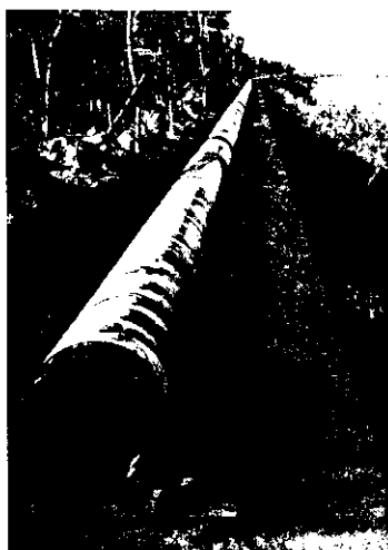
写真1 ルートおよび接合完了したパイプラインの概況
