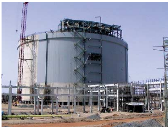
第 5 図 ペトロネット LNG 基地用コンクリートタンク（インド） Fig. 5 Concrete tank of Petronet LNG terminal project (India)
