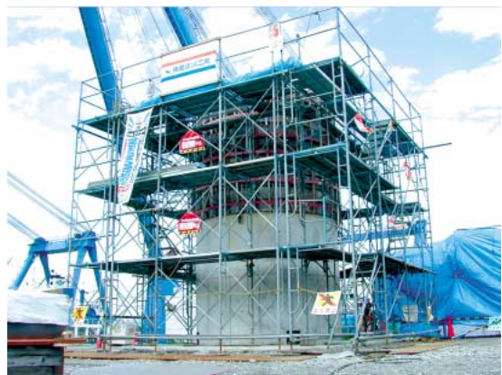
第 7 図 コンクリートキャスクの製作状況 Fig. 7 View of concrete cask construction
