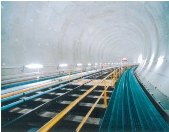
第 8 図 セグメント組立て完成後のトンネル全景 Fig. 8 General view of assembled concrete segments
