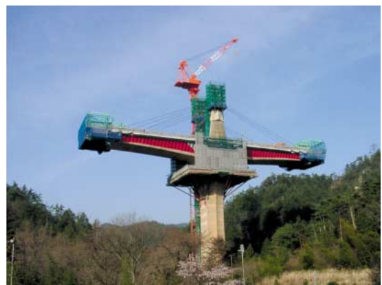
第 10 図 第二名神高速道路「栗東橋」 Fig. 10 View of "Rittou Bridge" construction (New Tomei and Meishin Expressway)
