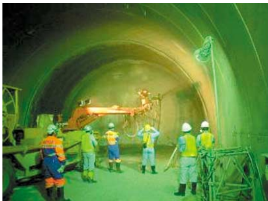
第 13 図 独立行政法人土木研究所における吹付け実験状況 Fig. 13 View of airless shotcrete test at Public works research institute
