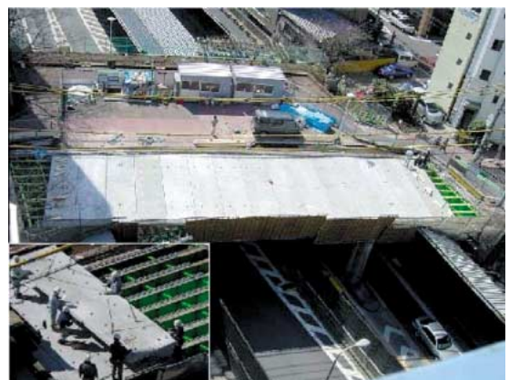
第 11 図 「新富橋」における HSL スラブ Fig. 11 View of HSL slab construction at "Sintomi Bridge"
