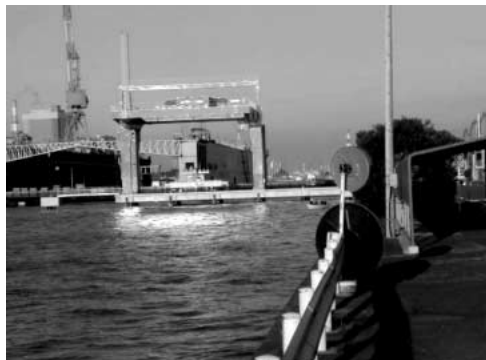
第3図 打設箇所 Fig. 3 Placing structures
