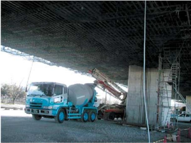
第 8 図 コンクリート打設状況 (ポンプ車)
