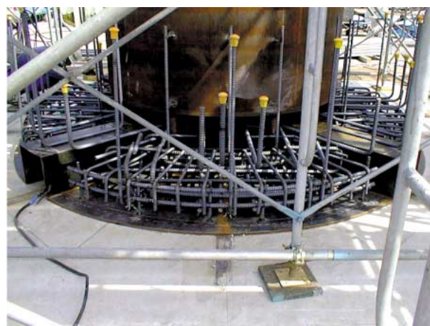
第 2 図 コンクリート製貯蔵容器試作体の製作状況（鉄筋組） Fig. 2 Placing of reinforcement
