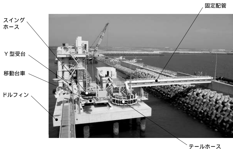
第9図 自動陸上排送装置の全景 Fig. 9 Automated discharge system
