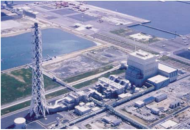
第 1 図 常陸那珂火力発電所全景 Fig. 1 General view of Hitachinaka Thermal Power Station
